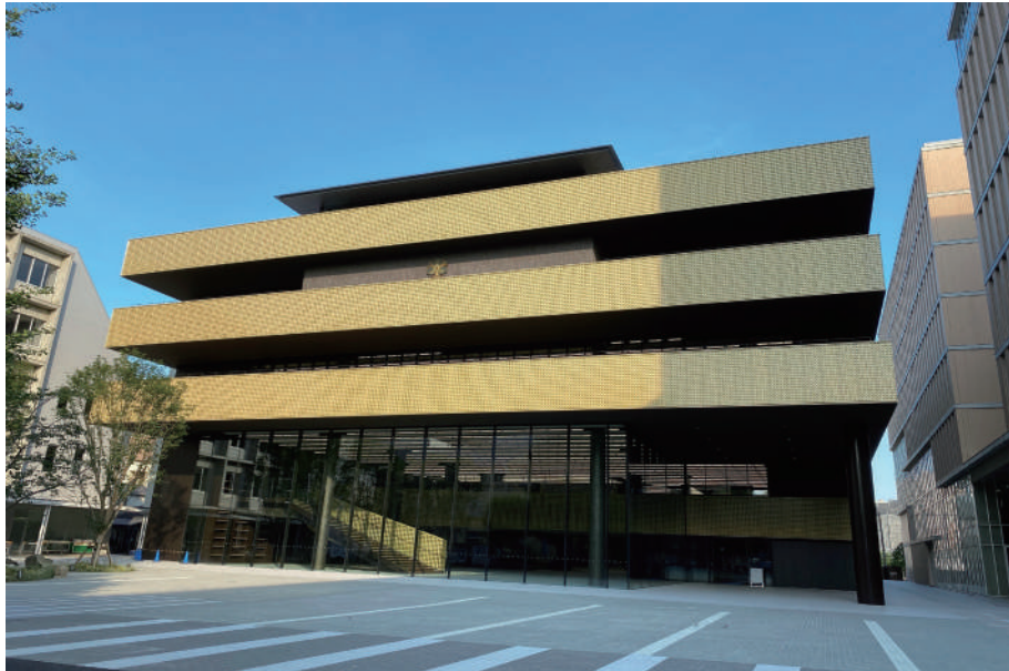
東京都豊島区西巣鴨にある大正大学 8号館 附属図書館&ラーニング・commons 2020年11月グランド・オープン
